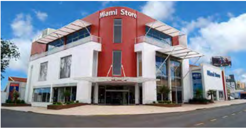
Loja localizada no Taquaral foi reformada e ampliada em toda sua estrutura recentemente
