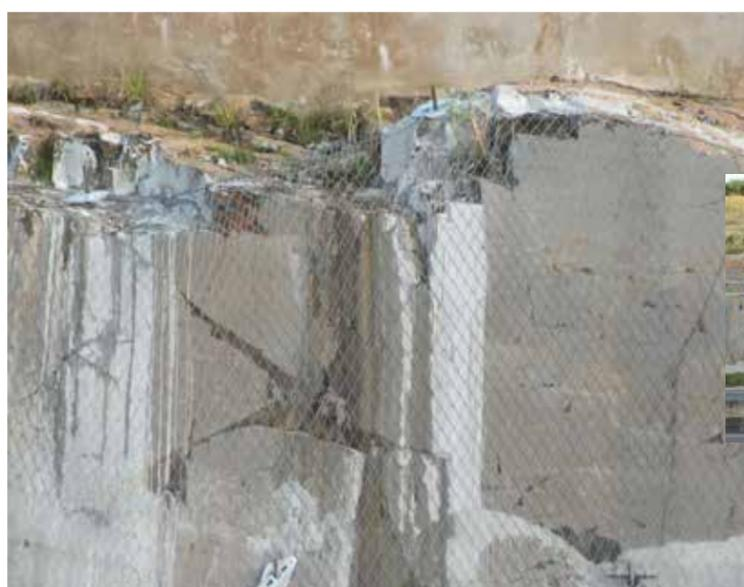
Tela metálica foi presa com pinos fincados na rocha: prevenção contra infiltração de água
