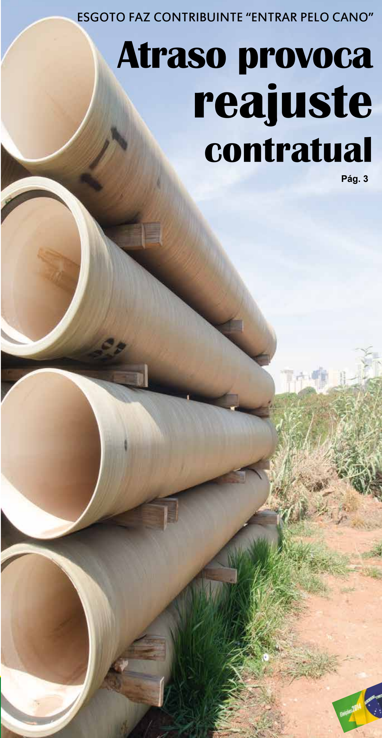
Tubos de PVC de 500mm que vão permitir a transposição sob a Rod. D. Pedro e por onde escoará o esgoto de três bairros (ao fundo)
