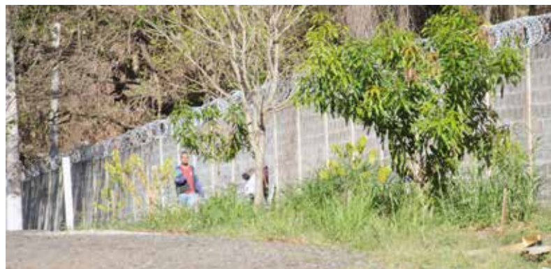
Apesar do arame no alto do muro, buracos permitem a entrada de qualquer um na mata
