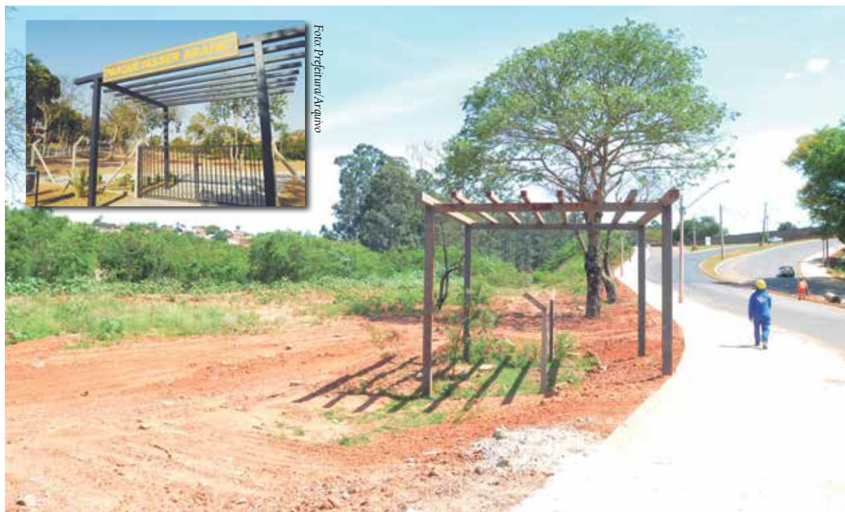
Da entrada do Parque, soterrada pelas obra da nova Avenida Prof. Dr. Alexandre Chiarine, só restou a armação de ferro que servia de portal
