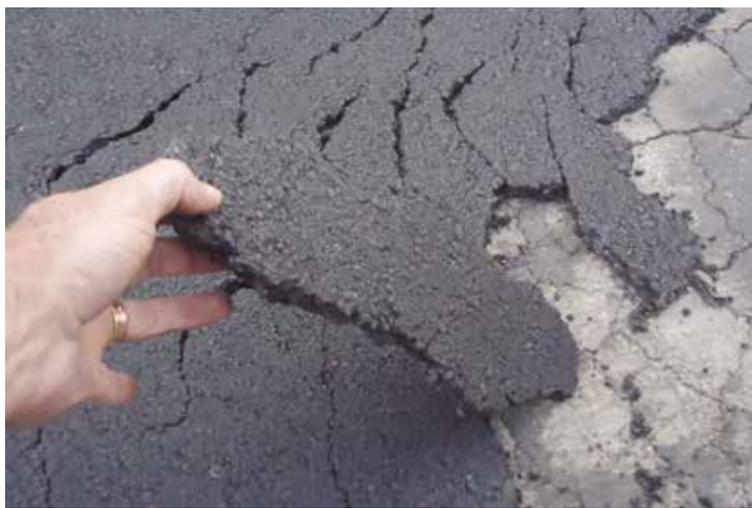
Massa formada por pedriscos solta por inteiro quando colocada sobre asfalto antigo
