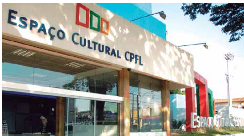
Bufê que funciona no espaço cultural da CPFL não tem vistoria do corpo de bombeiros
