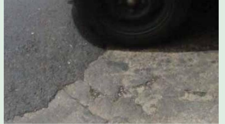
Rachaduras no asfalto velho infiltram água no remendo novo e o buraco volta
