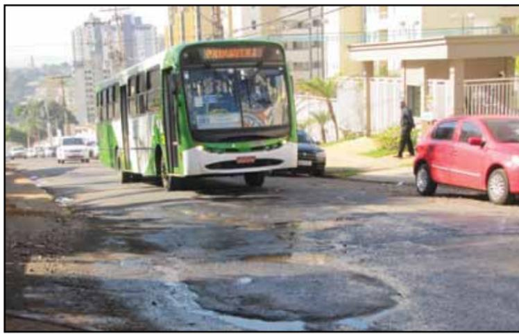
*Linhas de ônibus desviadas para a rua contribuem para o desgaste do asfalto. Só recape resolve*
