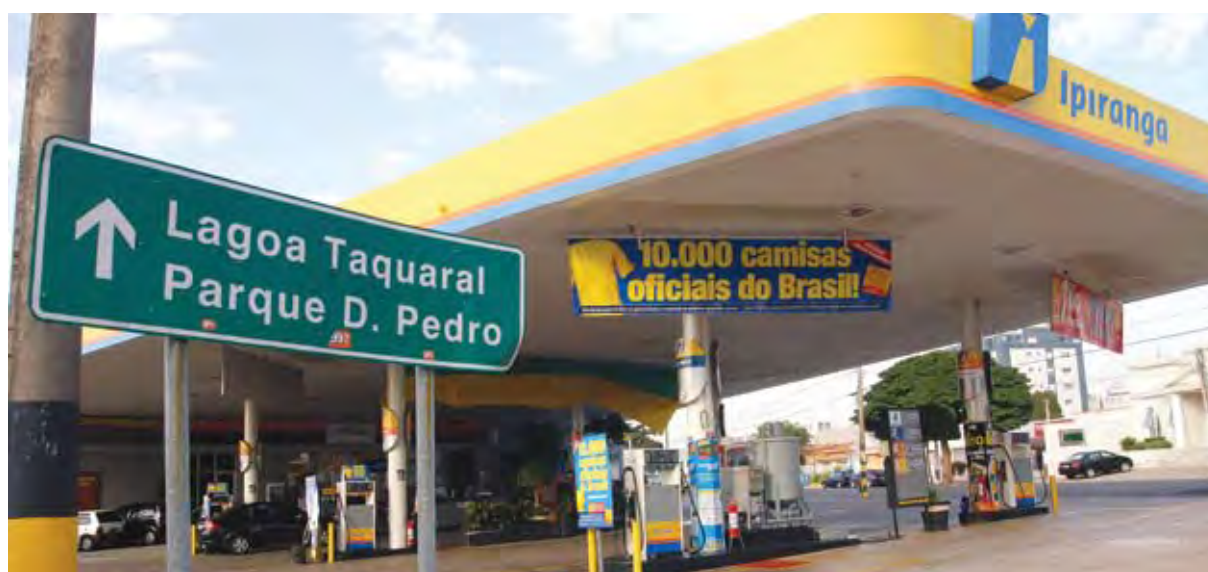
Serv Posto Oásis, da bandeira Ipiranga, localizado na Avenida Barão de Itapura, 2.890. Água superficial contaminada corre direto para a Lagoa do Taquaral
