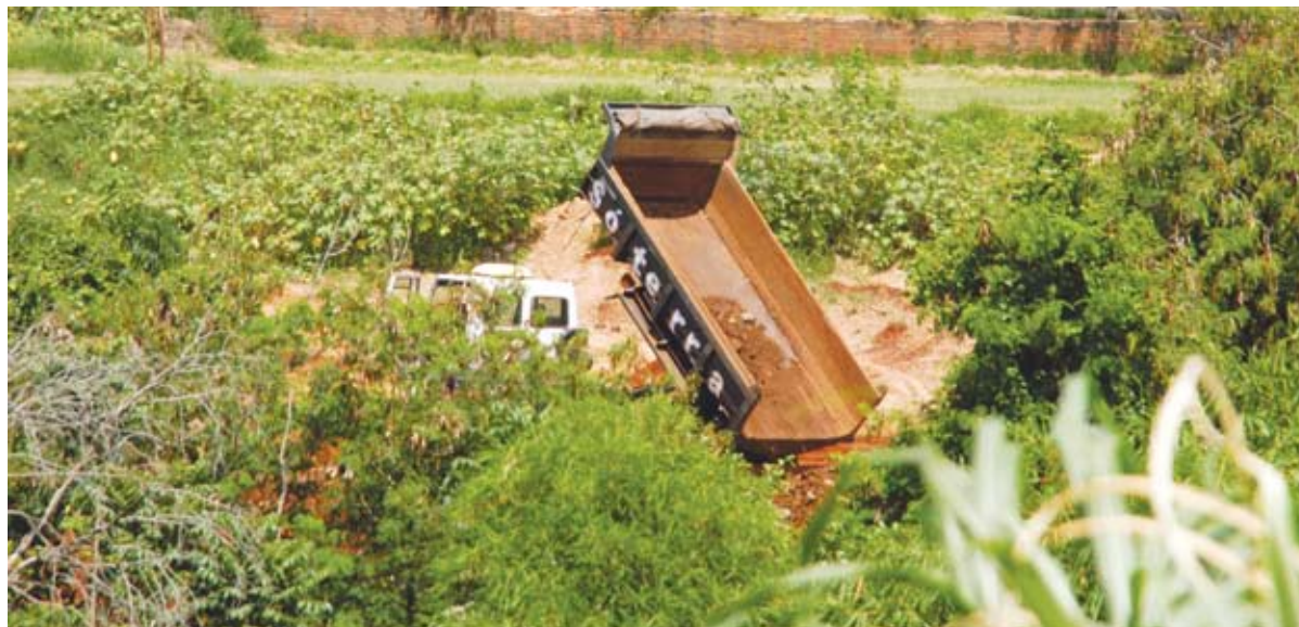
Caminhões da Só Terra despejam entulhos nas margens do córrego
