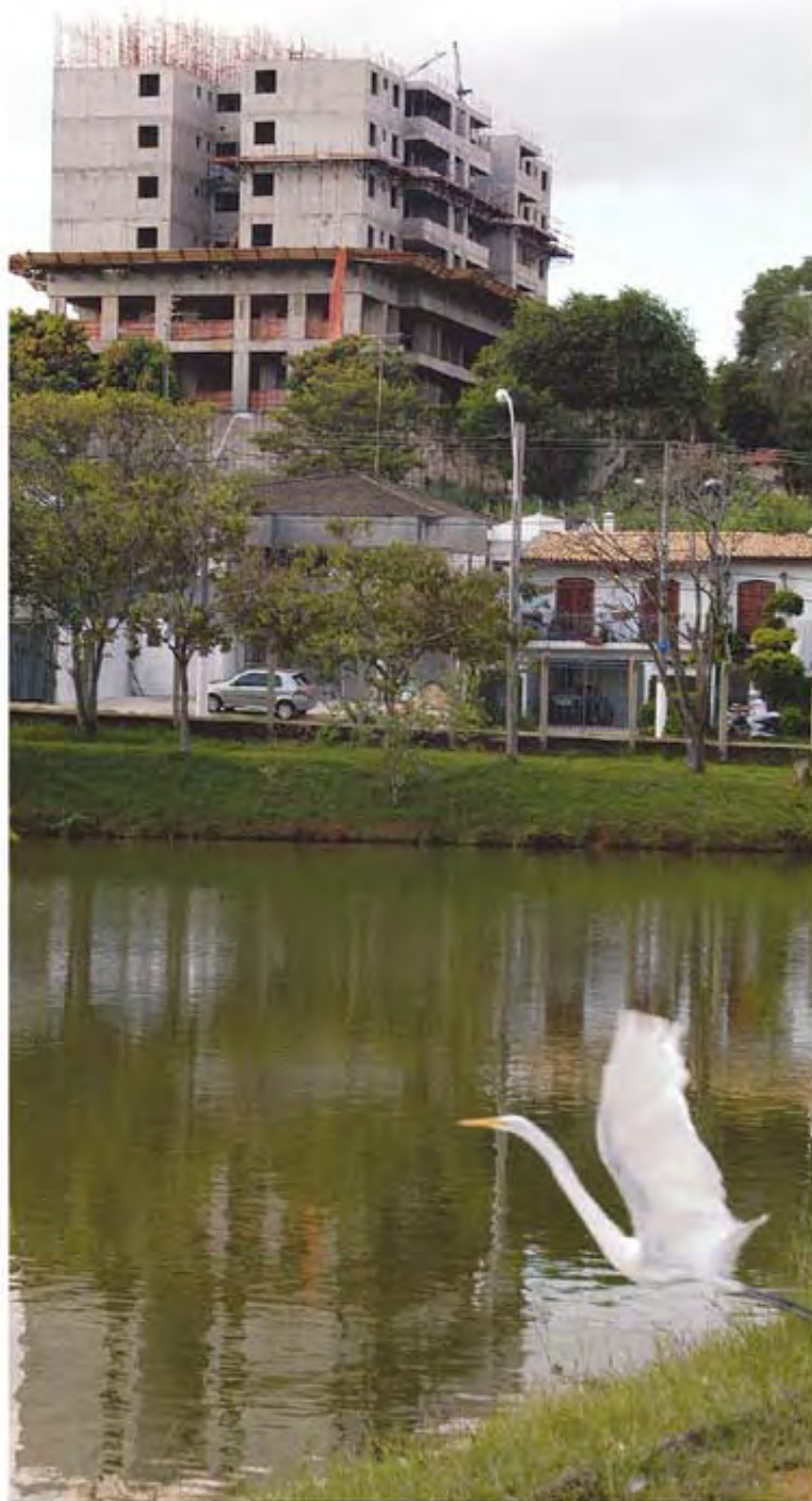
Enquanto aguarda a decisão da Justiça, prédio com a obra apenas iniciada vai se deteriorando
