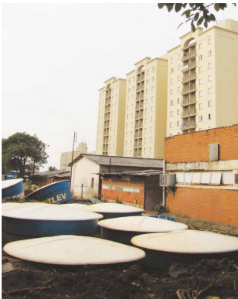
Equipamentos instalados no terreno ao lado do condomínio estão abandonados e deteriorando com o tempo
