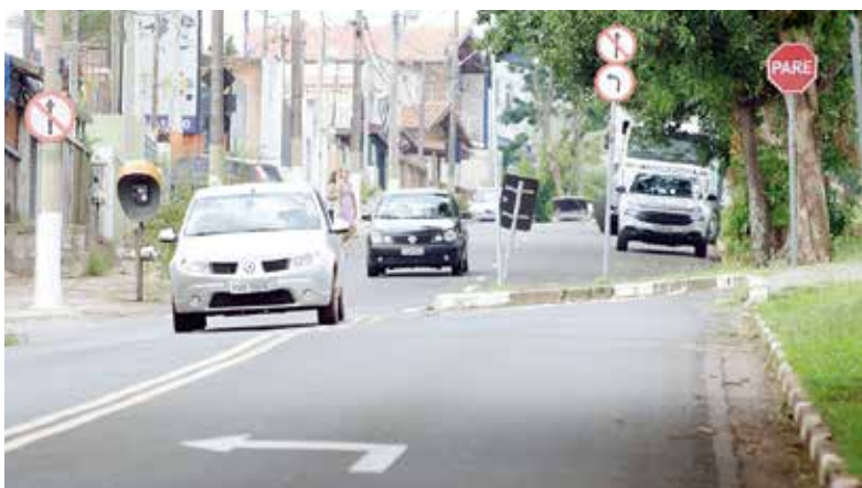
Moradores querem melhorias na sinalização, vertical e de solo, da Rua Luis Otávio. Perigo.
